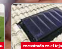
encastrado en el tejado
