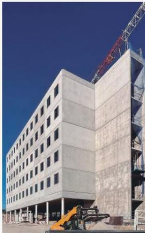
híbrido desarrollado por CREE Buildings, combinando un 80% de madera en pilares, vigas y fachadas con un 20% de hormigón en forjados y núcleos de comunicación. Este enfoque no solo redujo la huella de carbono del edificio, sino que también facilitó un proceso eficiente de montaje y desmontaje, teniendo en cuenta el ciclo de vida completo del hotel.
