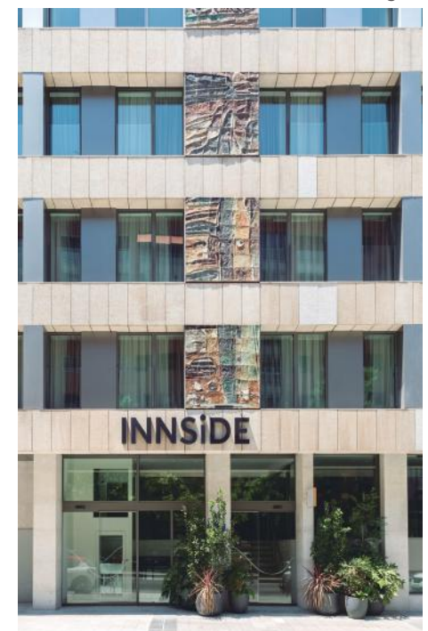
Foto: Rehabilitación del Hotel Meliá en Zaragoza
