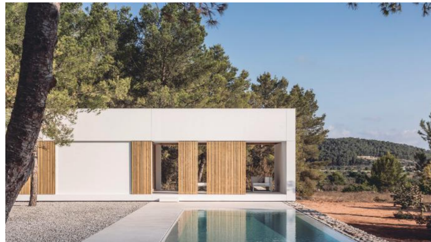
Foto: Proyecto ca l'amo (madera termotratada Lunawood) - Fotógrafo Marià Castelló - Gabarró Hermanos
