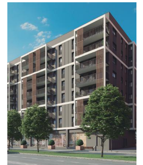
Foto: Edificio Címera. 66 viviendas en Viladecans
