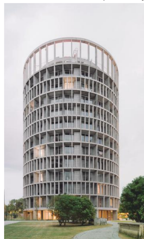
Foto: CORTIZO. Hoso Tower. Oporto. ©João Rey
