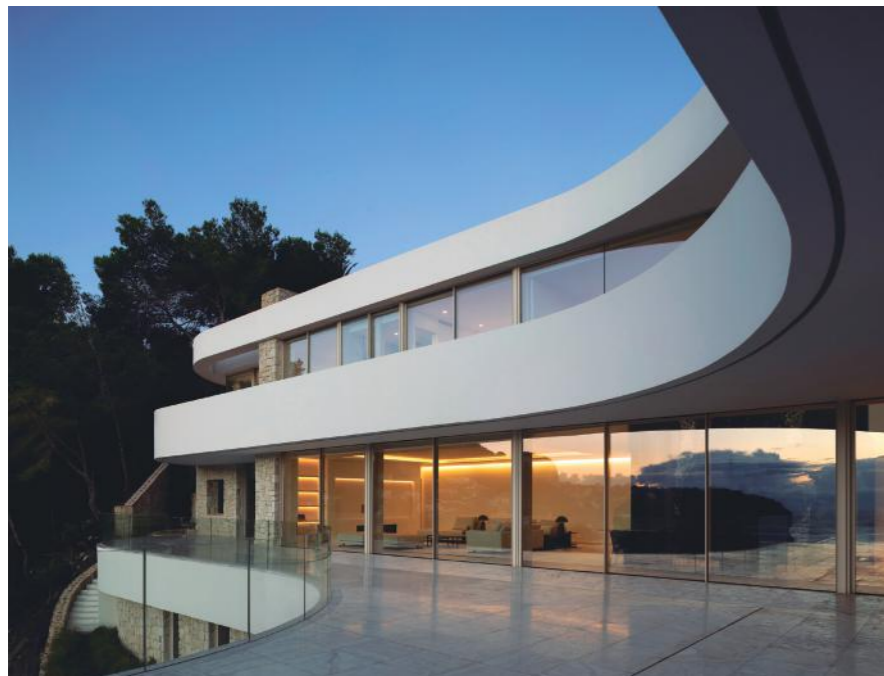
Foto: CORTIZO. Casa CT22. Pepe Giner Arquitectos, ©Diego Opazo
