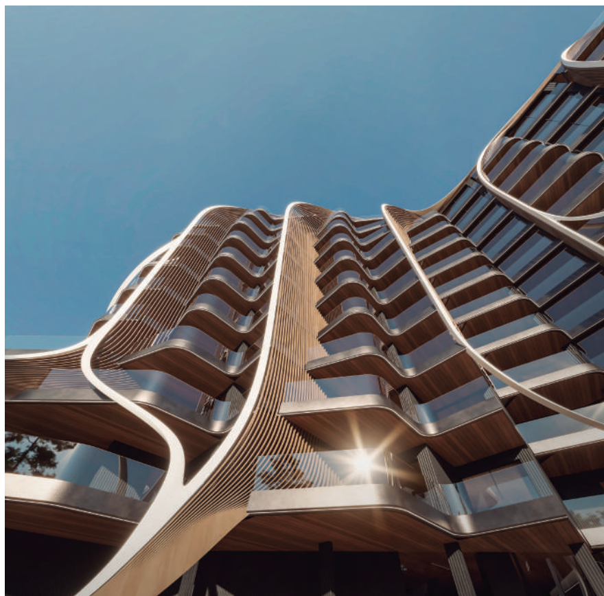
Foto: MORPH. Detalle de fachada
