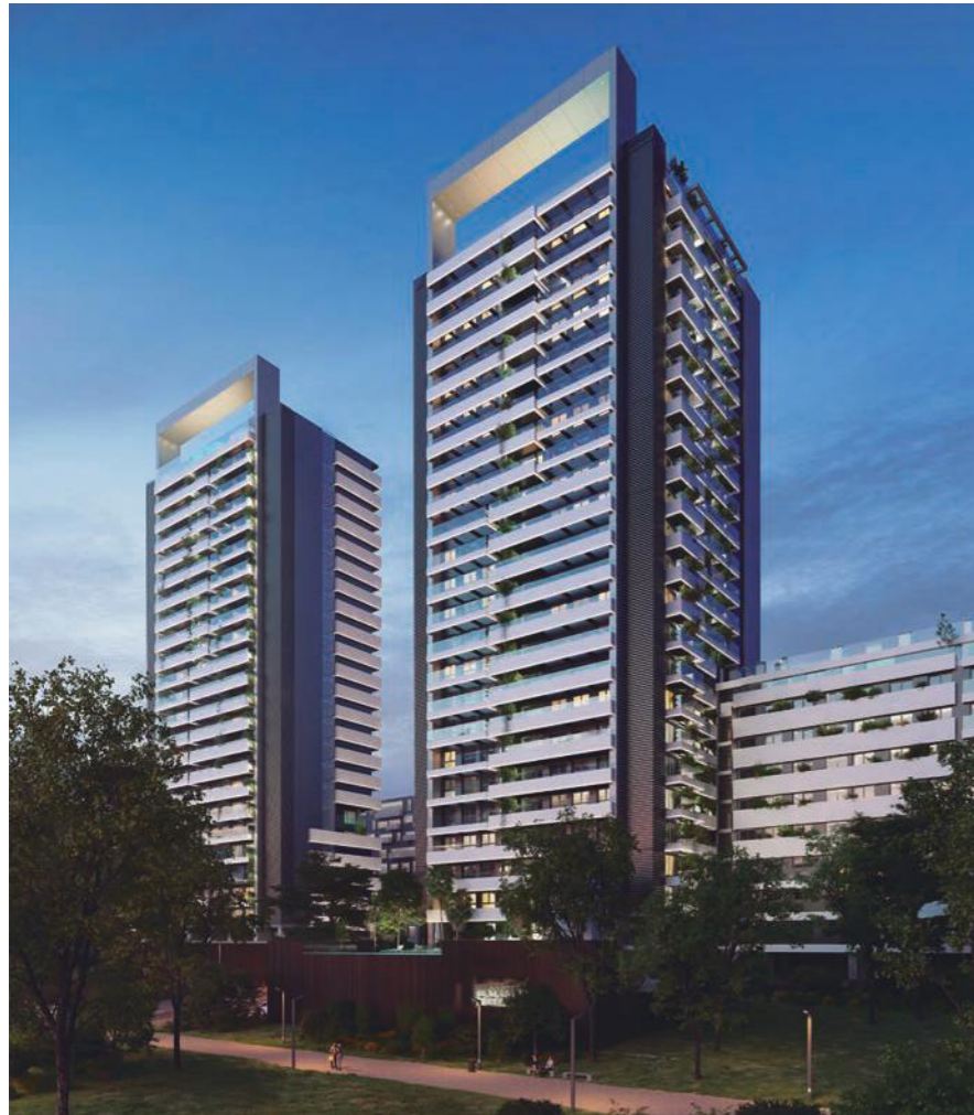
Foto: Torre Residencial
