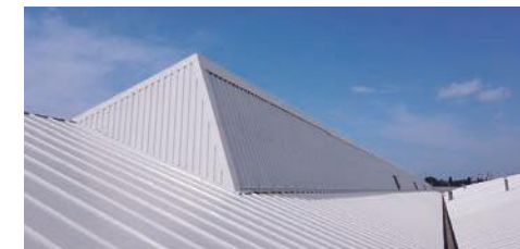
FOTO: Cubierta de los talleres centrales de Metro en Canillejas
