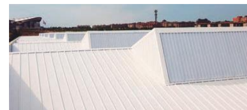
FOTO: Cubierta de los talleres centrales de Metro en Canillejas
