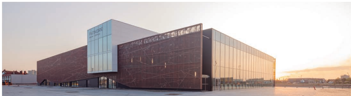
Fig. 1: El "Patinoire" de Dunkerque, en el Norte de Francia, es un edificio para actividad deportiva: el patinaje sobre hielo. Está caracterizado por su fachada de paneles de aluminio ligero perforado y recubrimiento en polvo, con acabado y color característicos (colección Patina Adapta Color, color Effervescent Earth). FOTO: Guillaume GUERIN
