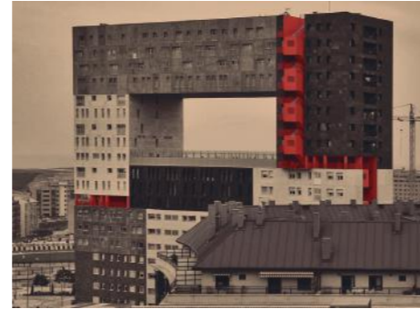
Foto: Edificio Mirador. 2000-2005
