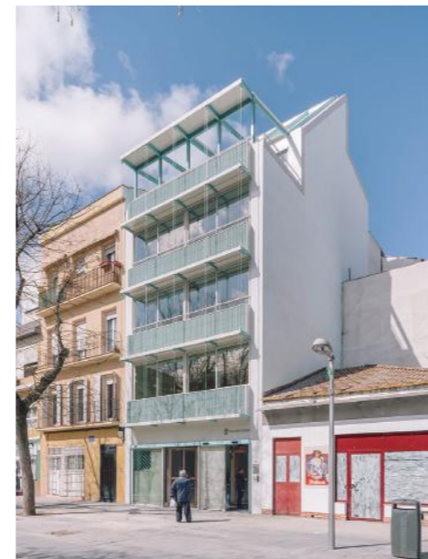
Foto: Save The Children. Centro de atención a la infancia. Rehabilitación de una edificación. (2016-2018)
