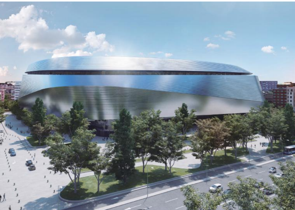
Foto: Remodelación Estadio Santiago Bernabeu, In progress. En colaboración GMP-L35 y RIBAS&RIBAS
