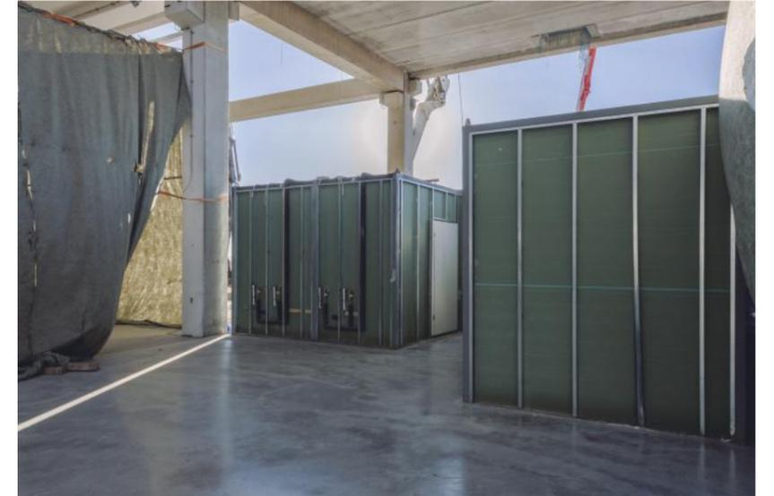
Foto: Nevo Construcciones Industrializadas: baño prefabricado
