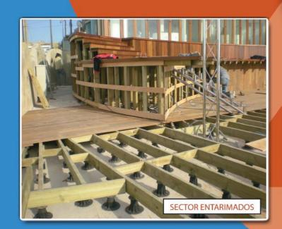
Columnas gran altura regulables Resistencia 1.000 kg
