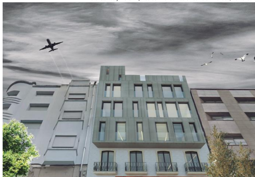
Foto: Santos y Mera Arquitectos - Rehabilitación edificio viviendas, Pontevedra
