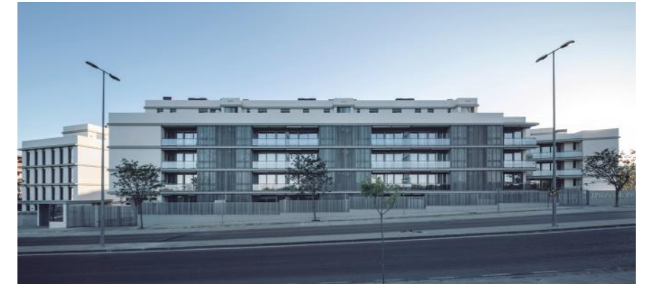
Foto: Gabriel Verd Arquitectos_Buró4 - Nueva Sede JJP Hospitalaria - Foto Jesús Granada
