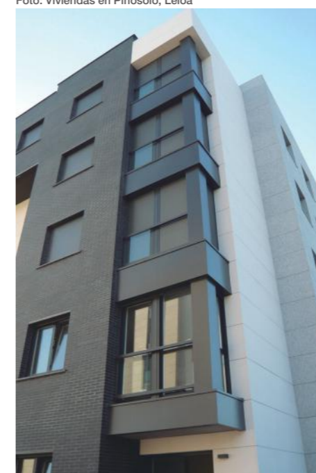
Foto: Viviendas en Pinosolo, Leioa
