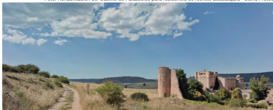
Foto: Rehabilitación del Castillo de Palazuelos para residencia de recreo, Guadalajara - David Frutos
