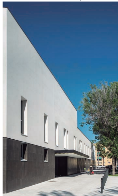
Foto: BCQ Arquitectura Barcelona
