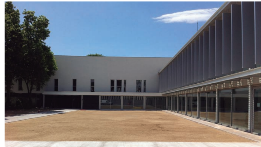
Foto: BCQ Arquitectura Barcelona
