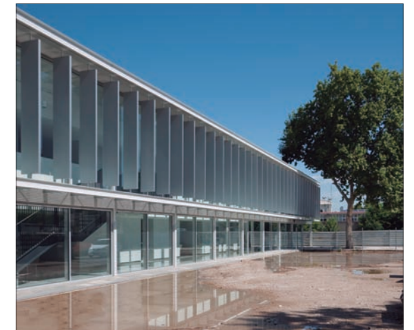
Foto: BCQ Arquitectura Barcelona
