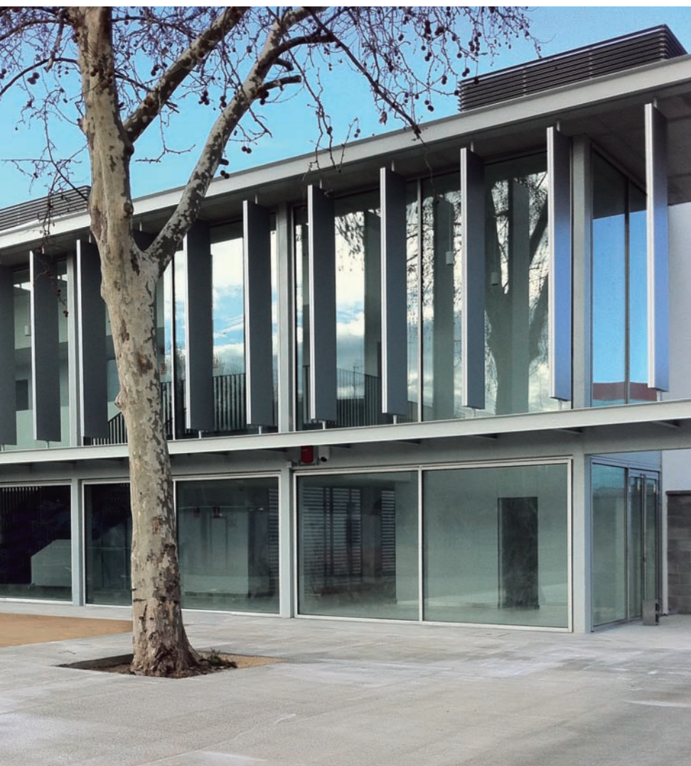
Foto: BCQ Arquitectura Barcelona
