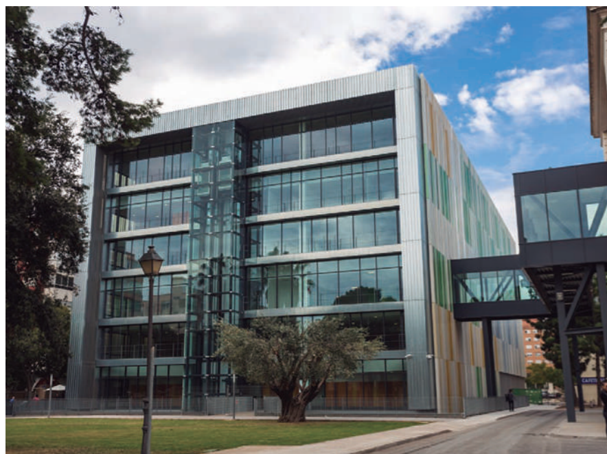
Foto: Bloque Quirúrgico Hospital General Universitario. Valencia
