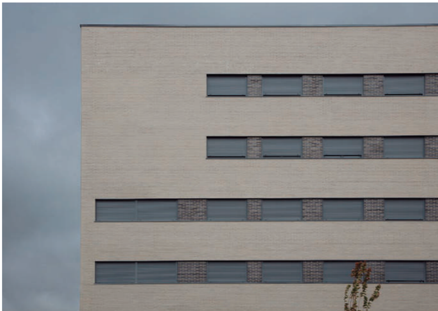
Foto: 18 viviendas en Fuenlabrada
