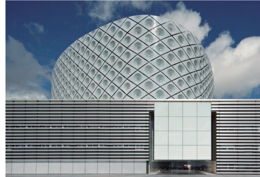
Foto: Hospital Rey Juan Carlos, Móstoles, Madrid. Duccio Malagamba
