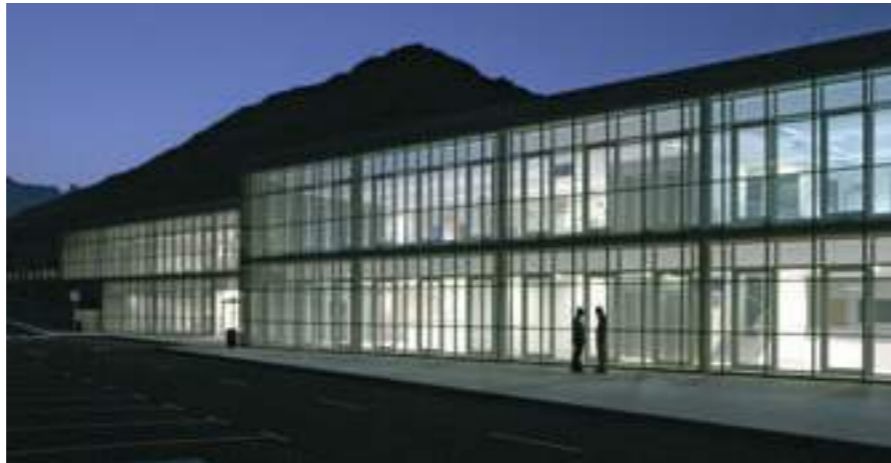
Fachada Principal. Foto: Luis Asín / Carvajal Casariego
