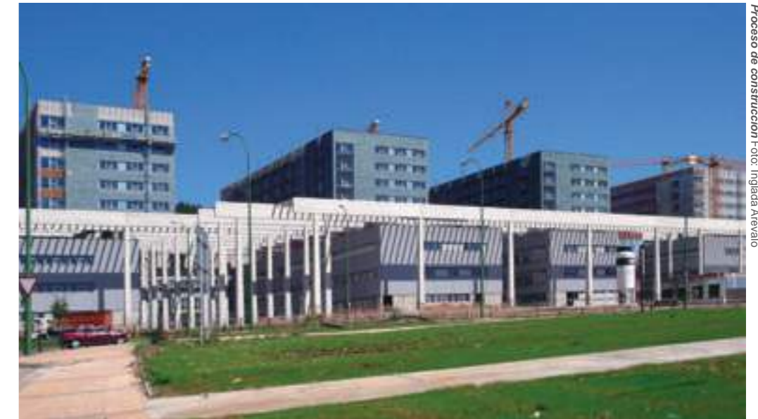
Proceso de construcción. Foto: Inglada Arévalo
