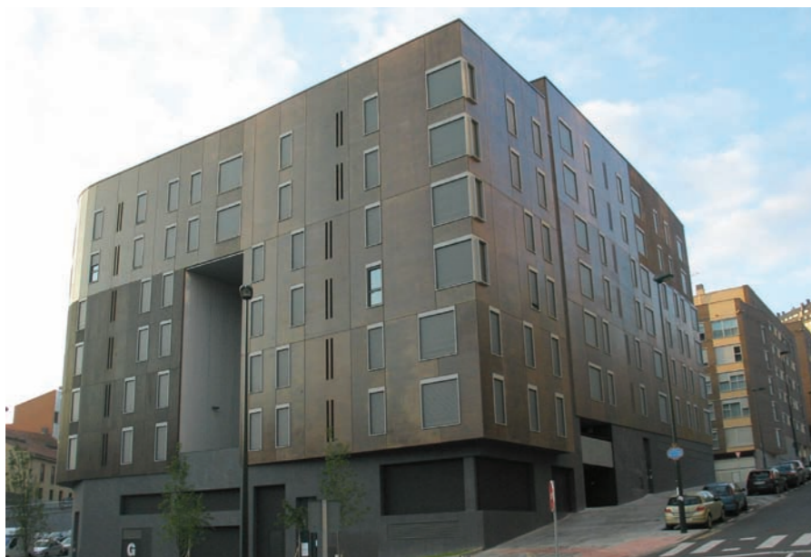
Esquina baja del edificio
