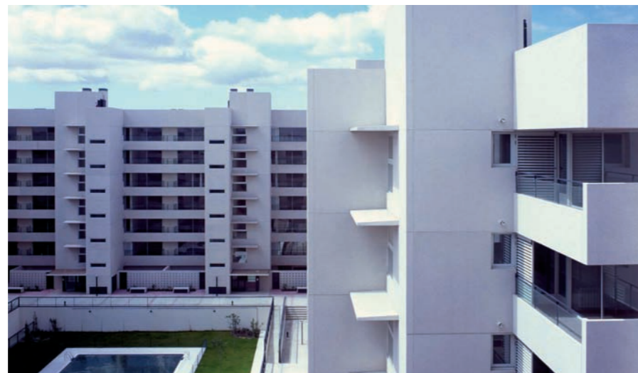
Viviendas en Las Tablas. Foto: Preinco
