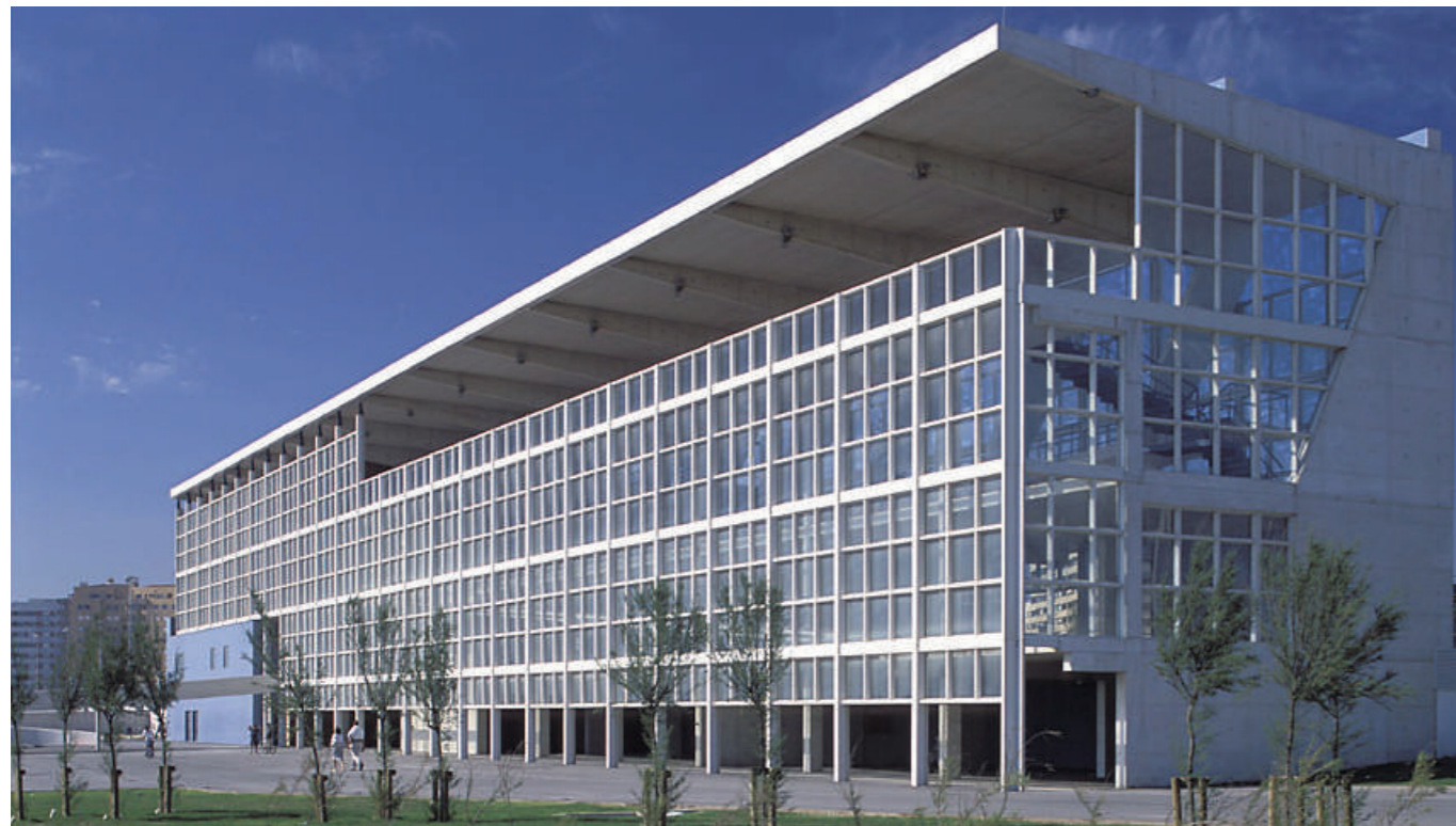
Edificio Transparente Porto. Foto: Abriga-Pregaia
