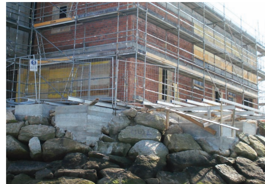
Detalle del muelle en obra. Foto: Díaz & Díaz Arquitectos
