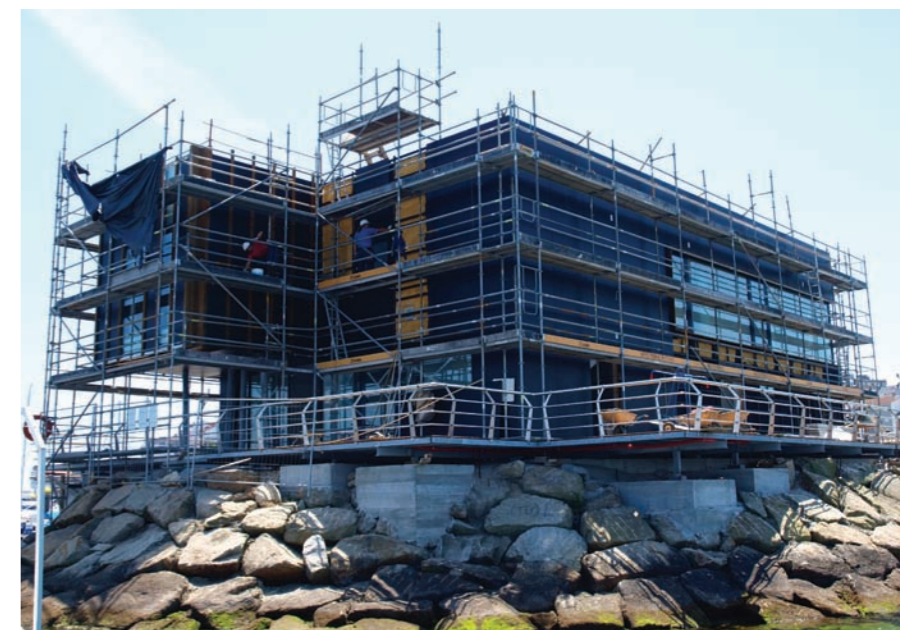
El edificio durante la obra. Foto: Díaz & Díaz Arquitectos
