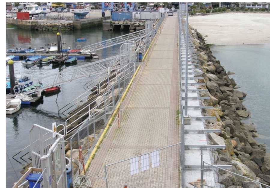
Ampliando la pasarela. Foto: Díaz & Díaz Arquitectos
