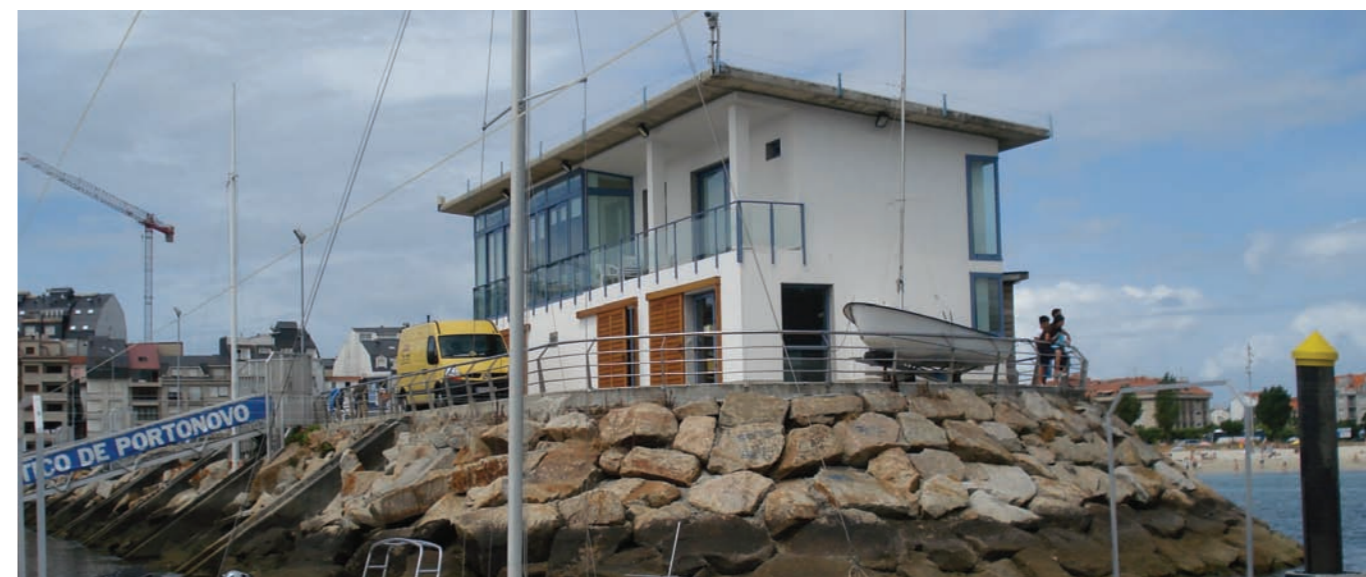
Antiguo edificio antes de la rehabilitación del mismo
