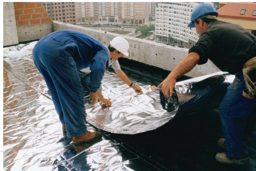
Cubierta plana. Foto: Padreiro-Tripomant.
