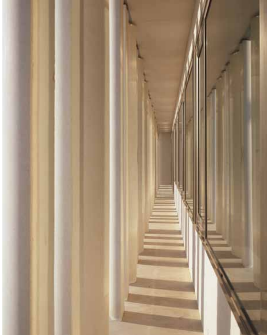
Pasarelas de mantenimiento tras la lamas de GRC. Foto: Roland Halbe
