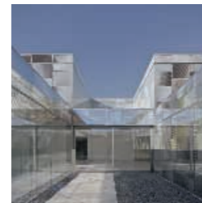
Detalle del patio exterior, que conecta con el interior mediante las grandes correderas Galene de Technal.
