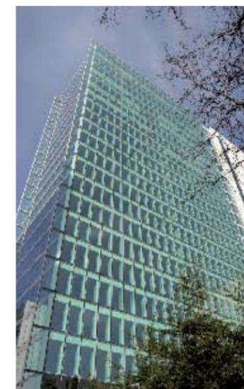
Las capas de óxidos y compuestos metálicos depositadas sobre los vidrios en un espesor de unas decenas de nanómetros, interfieren con las radiaciones solares modificando sus propiedades de transmisión y reflexión tanto luminosa como energética, además de la emisividad de su superficie. Así se obtienen diferentes estéticas y una amplia gama de productos con diferentes niveles prestacionales en sus propiedades energéticas.
