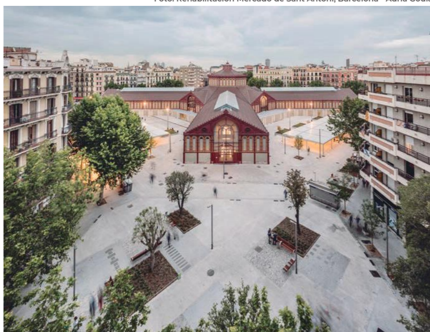
Foto: Rehabilitación Mercado de Sant Antoni, Barcelona - Adrià Goula
