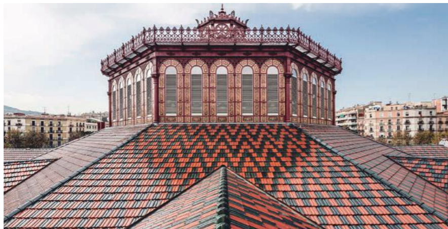
Foto: Rehabilitación Mercado de Sant Antoni, Barcelona - Adrià Goula
