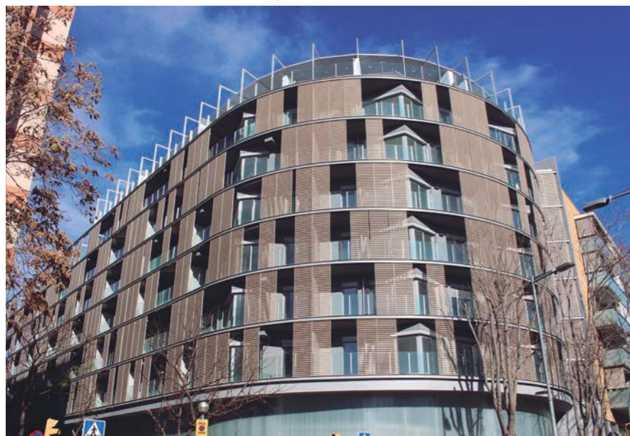
Foto: García Faura. Rehabilitación Edificio Hospitalet
