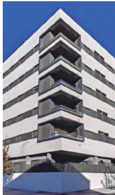
Foto: Residencial Parque Ingeniero Villaverde, Madrid
