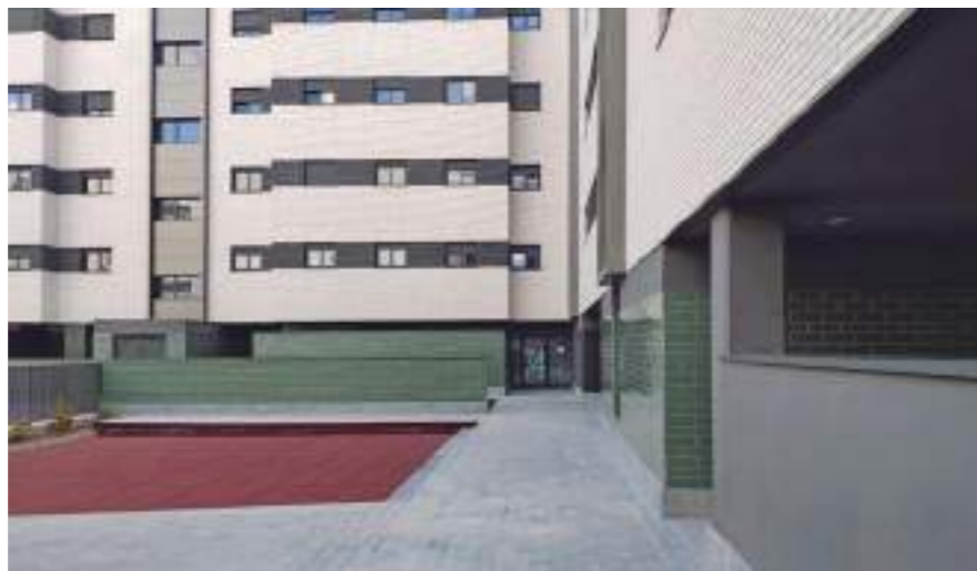
Foto: Residencial Parque Ingeniero Villaverde. Madrid
