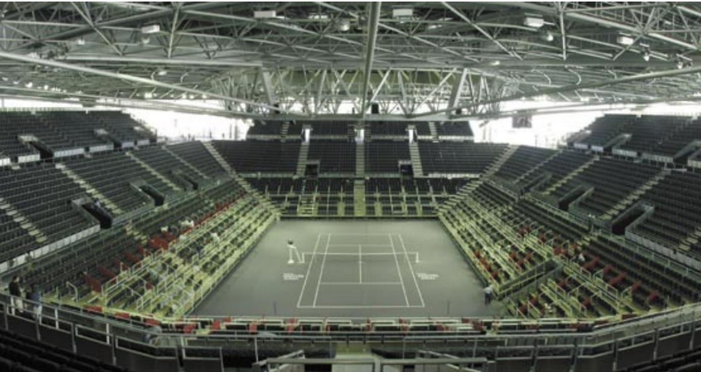
Fotografía de las claves del interior del recinto: gradas y cúpula son las piezas básicas del proyecto Telefónica Arena Madrid. (foto: Waagner Biro AG)
