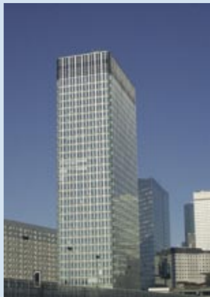
La torre Initiale, diseñada por Jean de Mailly y Jacques Depusse, contó con la participación de Jean Prouvé, que desarrolló la imponente estructura en acero para que su fachada pudiera albergar una piel acristalada, novedosa en Francia cuando se edificó la torre, en el año 1966.
