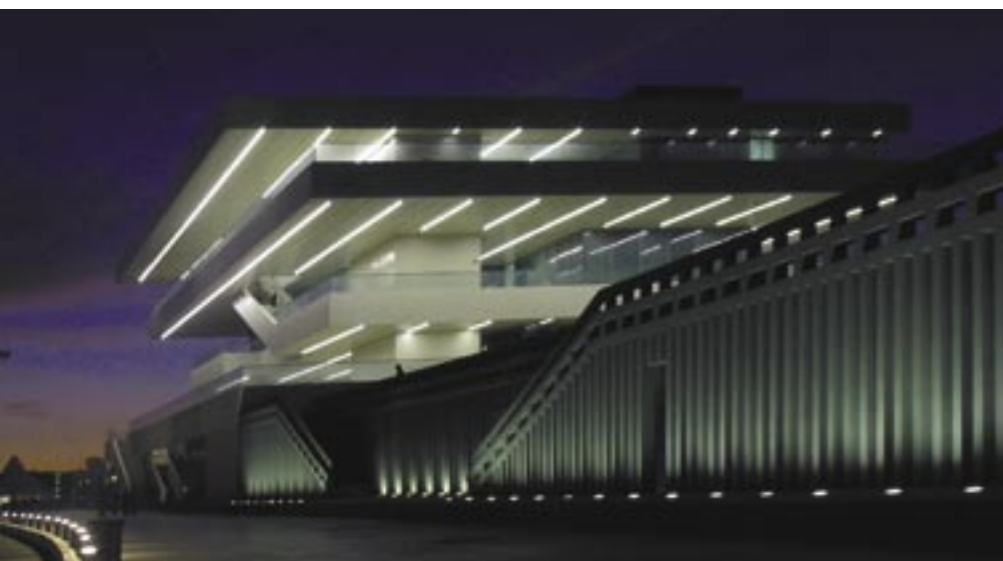
Fotografía: Artec Luminotecnia
