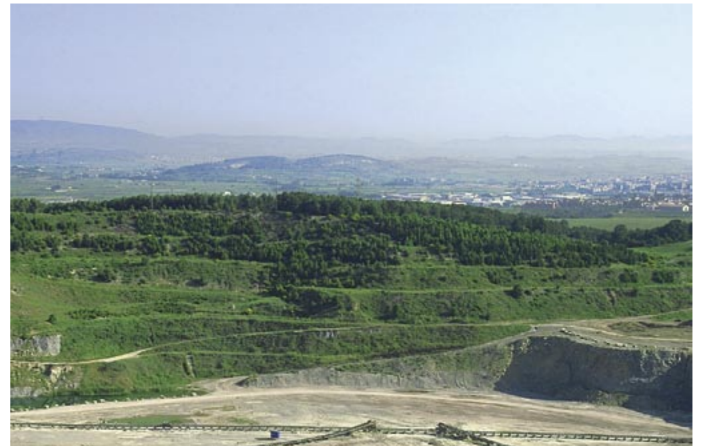
Cantera de Cemento. Foto: Uniland
