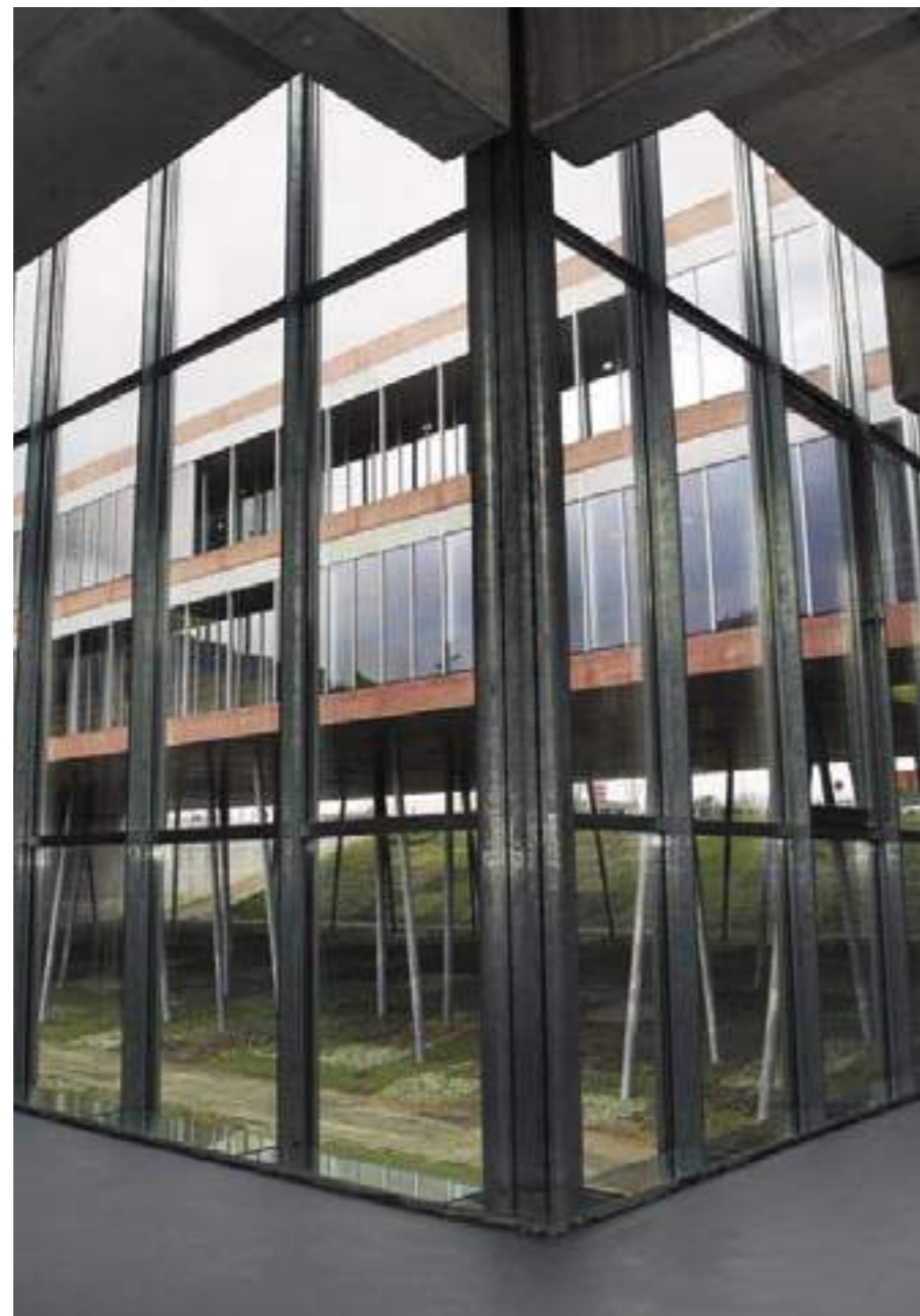
Vista del volumen elevado y el bosque de pilares desde la zona de laboratorios. Foto: Alberto Nevado
