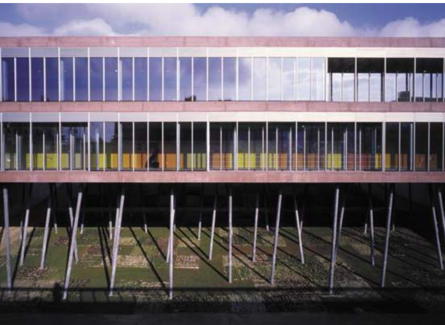
Detalle del bosque de pilares bajo el prisma, donde una galería proporciona los accesos a las aulas en ambas plantas del volumen. Foto: Luis Asín
