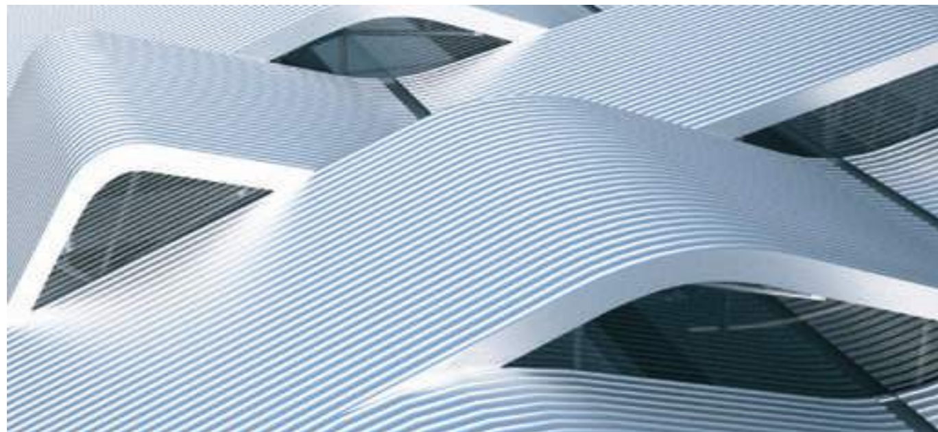
Sobre estas líneas, detalle de la cubierta y los ojos provocados para el acceso de la luz hacia el interior de la terminal.
