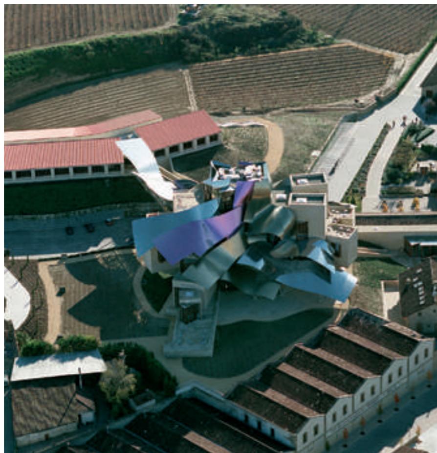
Vista aérea del Hotel Bodega Marqués de Riscal, diseñado por Gehry en Elciego, Álava. Foto: Intemper
