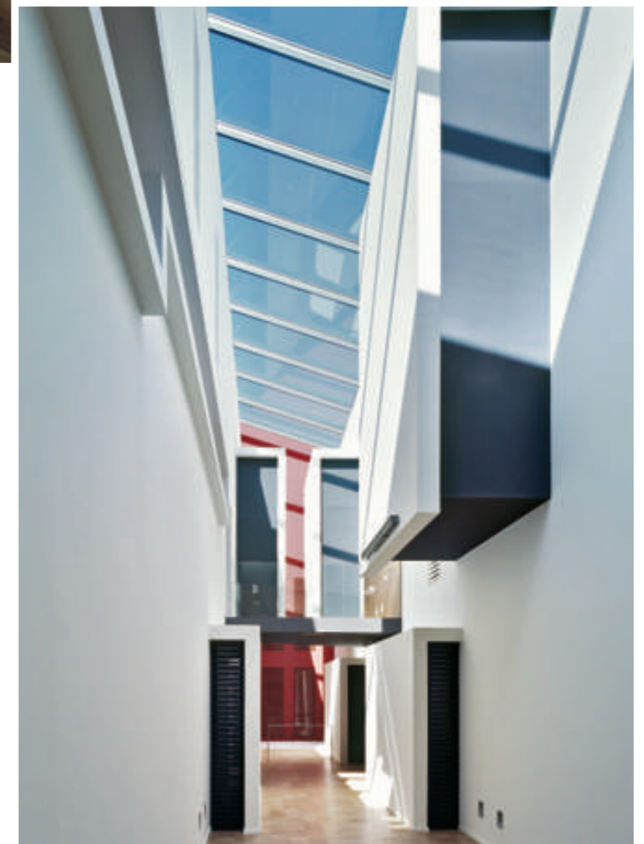
Patio Central con iluminación cenital mediante lucernario de vidrio. Foto: GCA
