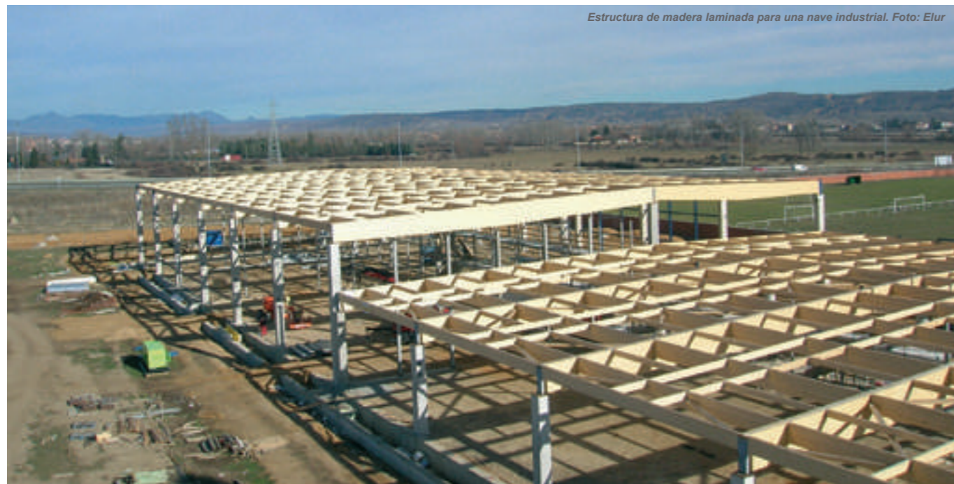
Estructura de madera laminada para una nave industrial. Foto: Elur
