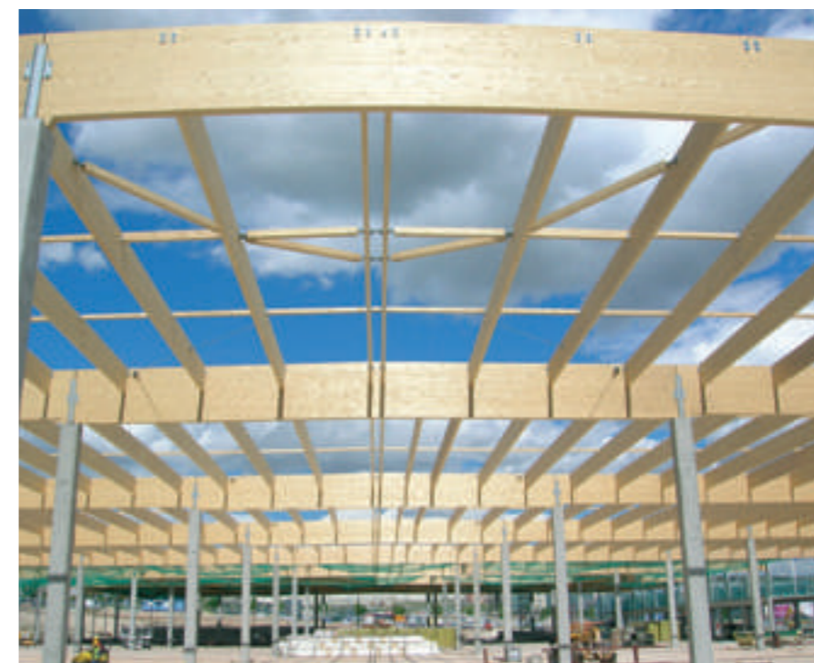
Estructura para Nave Comercial en Rivas Vaciamadrid. Foto: Elur
