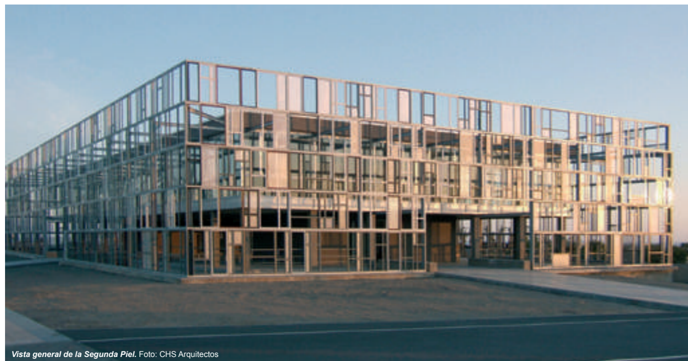
Vista general de la Segunda Piel. Foto: CHS Arquitectos
