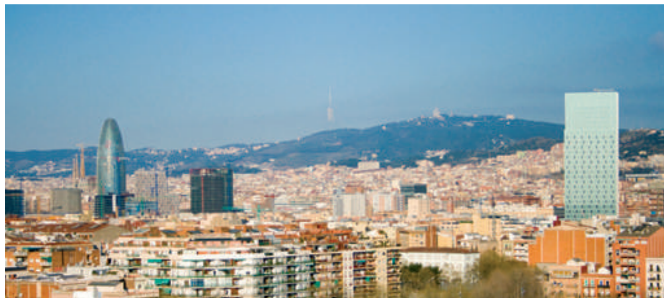
Los edificios nuevos son más propensos a sufrir el Síndrome del Edificio Enfermo. Foto: Promateriales
