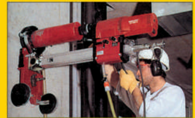
• Grandes taladros en hormigón
