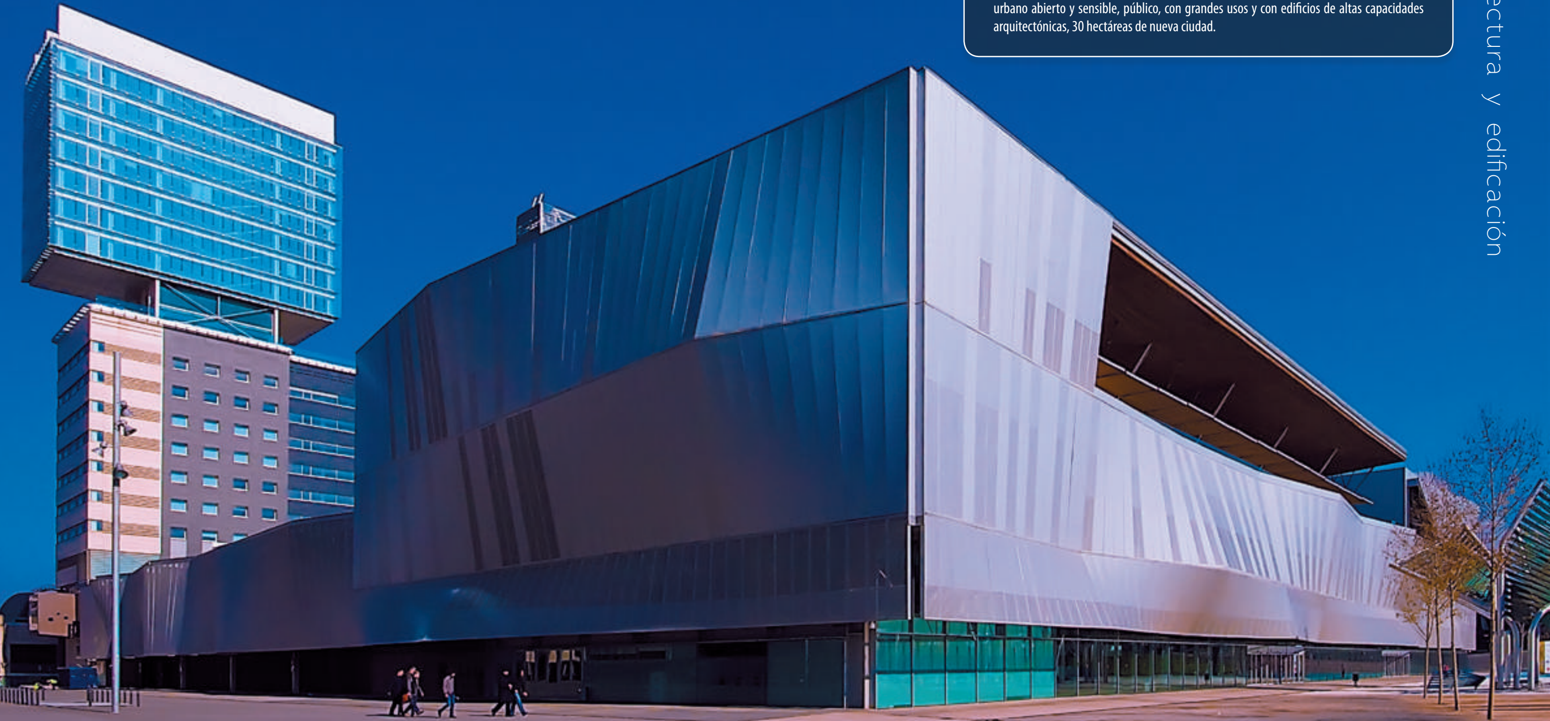
Fachadas Sur y Este del Centro de Convenciones. Foto: Promateriales
