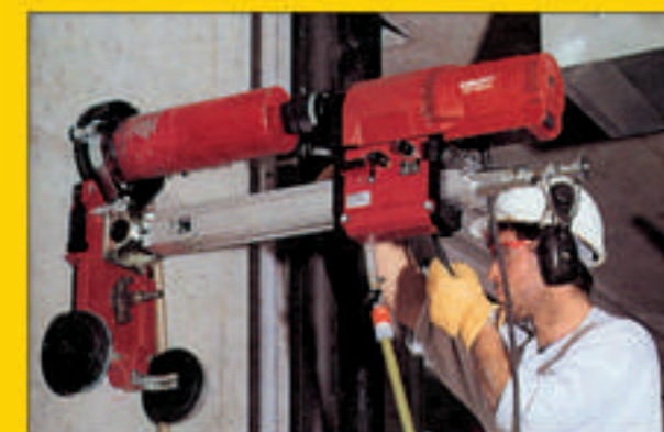
• Grandes taladros en hormigón
