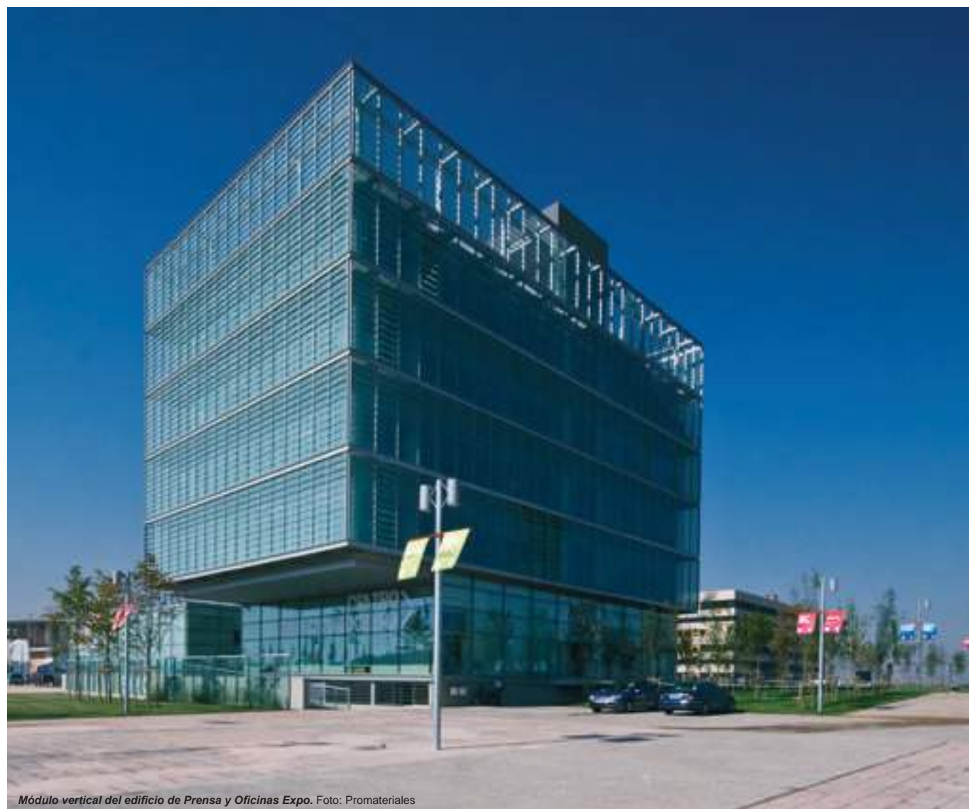
Módulo vertical del edificio de Prensa y Oficinas Expo. Foto: Promateriales
