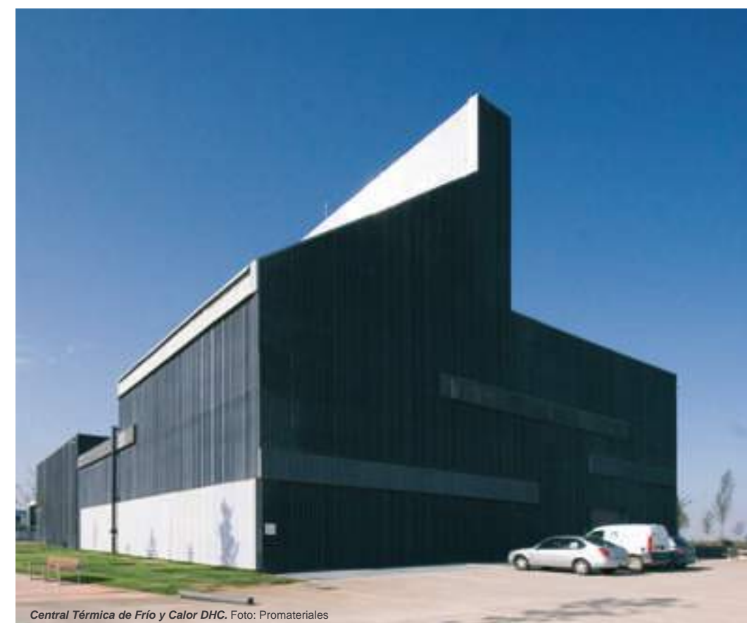
Central Térmica de Frío y Calor DHC. Foto: Promateriales
