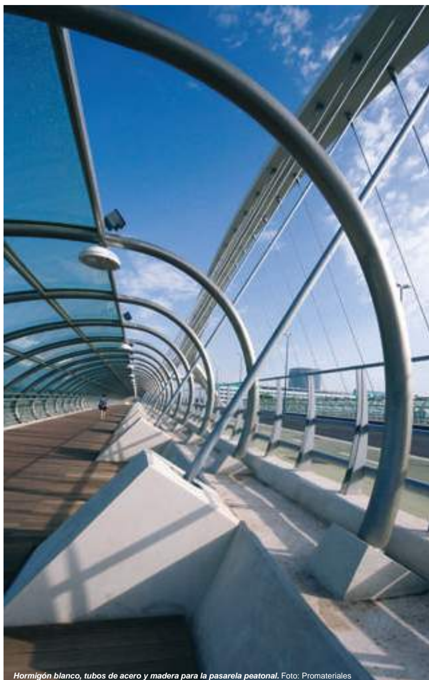
Hormigón blanco, tubos de acero y madera para la pasarela peatonal. Foto: Promateriales
