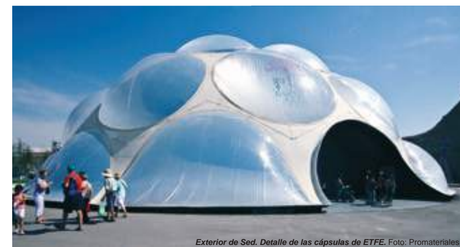
Exterior de Sed. Detalle de las cápsulas de ETFE. Foto: Promateriales
