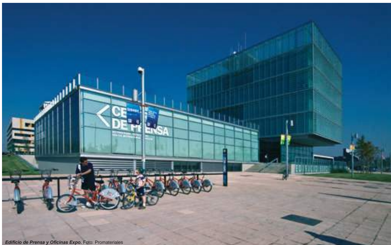
Edificio de Prensa y Oficinas Expo. Foto: Promateriales
