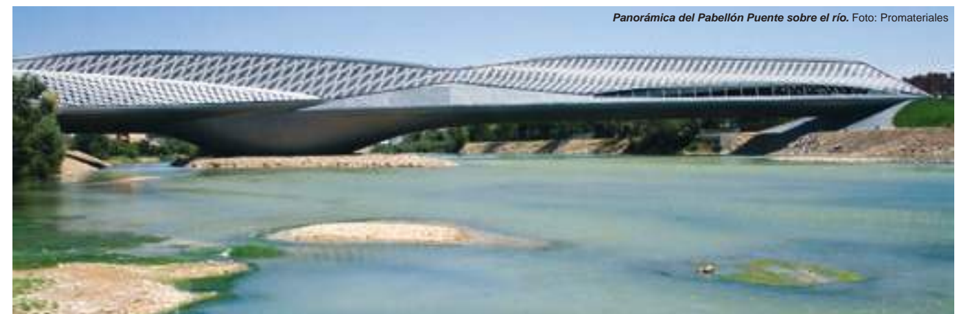
Panorámica del Pabellón Puente sobre el río. Foto: Promateriales
