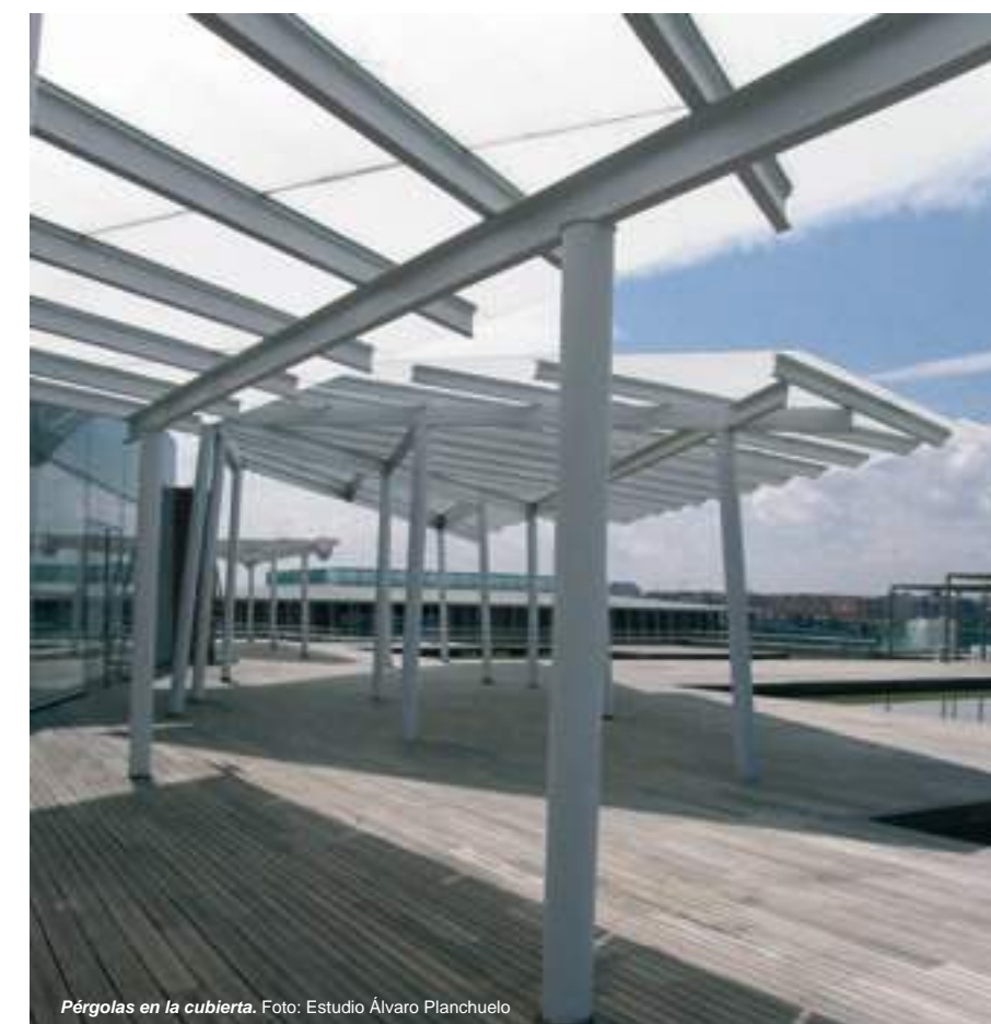
Pérgolas en la cubierta. Foto: Estudio Álvaro Planchuelo
