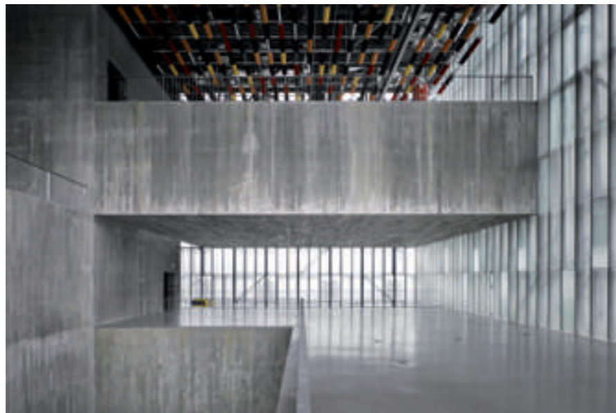
Centro de las Artes de La Coruña
