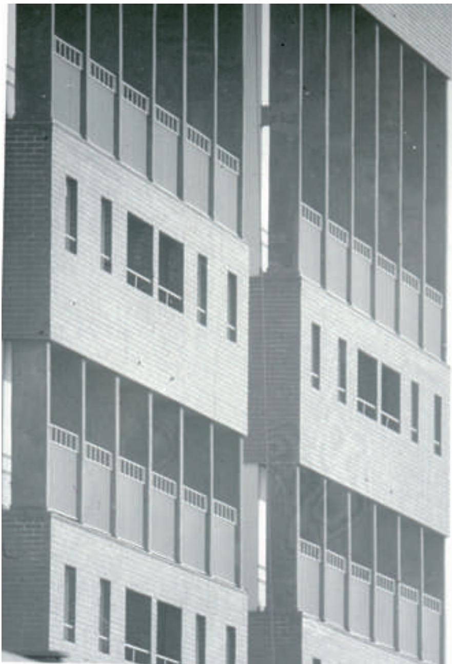
Edificio de Viviendas. Jerónimo Junquera
