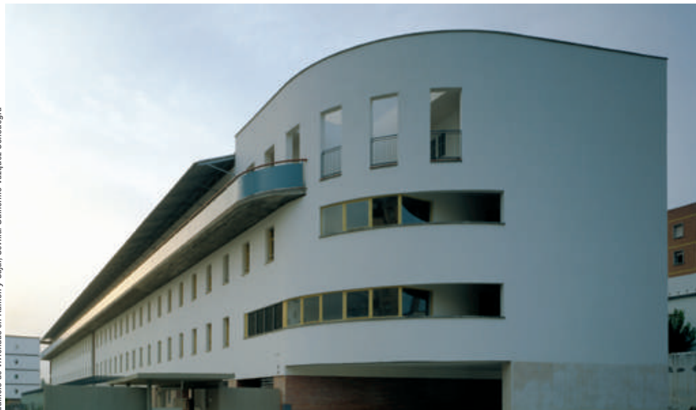
Edificio de Viviendas en Ramón y Cajal, Sevilla. Guillermo Vázquez Consuegra
