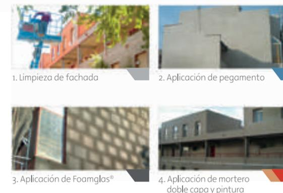
Con la colaboración de Ibercal® y Pamersa, Foamglas® ha desarrollado un proceso único para el rejuvenecimiento de fachadas y obra nueva, compatible con cualquier sistema de construcción. El Sistema Foamglas®-Ibercal® permite aislar desde el exterior de la vivienda, sin pérdida de espacio habitable.
